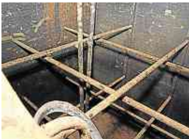
Mit einem eigenen Tiefbrunnen versuchte man die Trinkwasserversorgung sicherzustellen.
