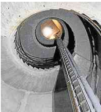
Der Kühlturm war gleichzeitig auch als Notausstieg gedacht. Er war die Achillesferse des Bunkers.
